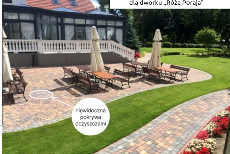
Oczyszczalnia zainstalowana dla dworku „Róża Poraja”
