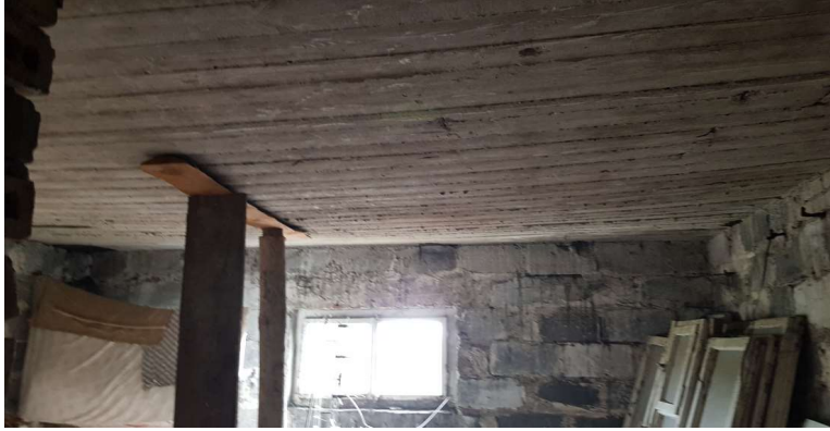
POMIESZCZENIE 2 - tam jest widoczne ugięcie stropu, strop został podparty belkami drewnianymi.
